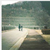
冬季 長野県 木祖町 呼峰川ダム
